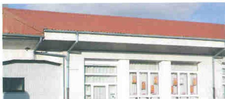
Rénovation de la toiture de l'école maternelle. Après l'enlèvement des mousses et le lavage de la toiture, application d'un produit anti-mousse et d'une peinture de type protectoiteinte rouge terralite. Travaux réalisés par l'entreprise « Toits Nets » de Ste Marie. Montant des travaux : 11300 €
