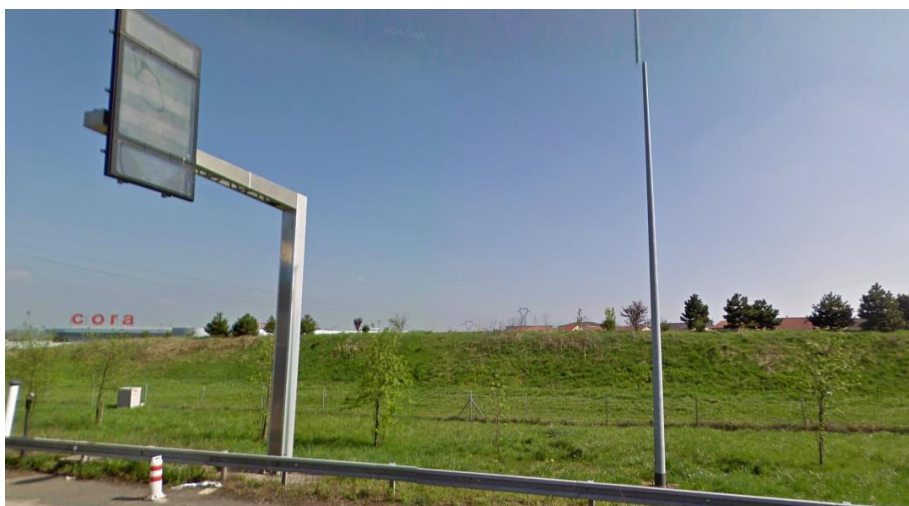
Merlon au niveau du merlon du péage de la bretelle, clôture en contre- bas et glissière de sécurité
